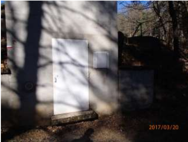
Accès chambre de vannes et coffret EDF
