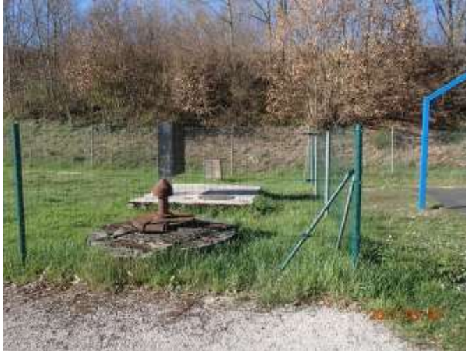
Coffret de comptage, Regard de vannes, coffret de commande et tête de forage
