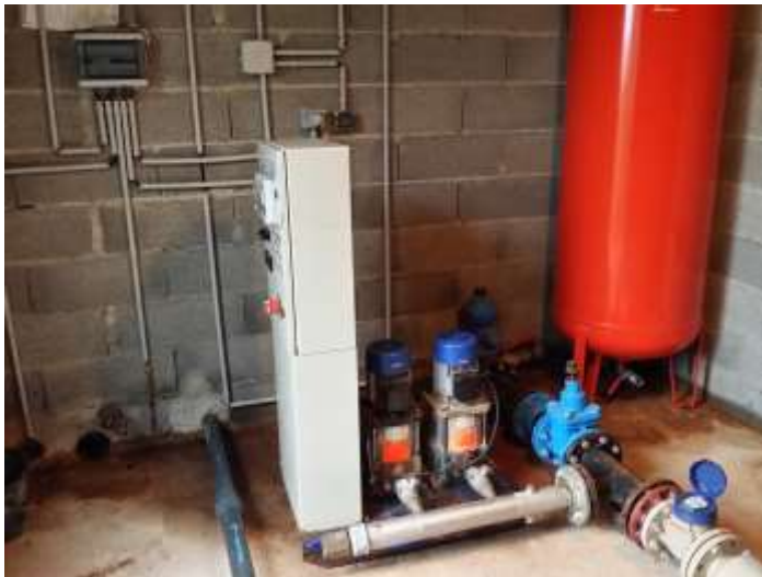
Surpresseur distribution de Malvézy
