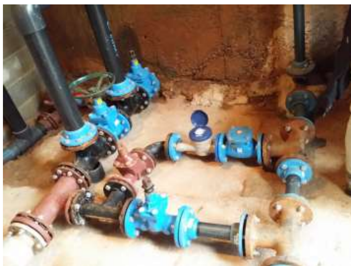
Arrivée refoulement, distribution, by pass et distribution gravitaire Miège Rivière
