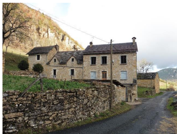
Exemple de restauration dans le respect de la typologie caussenarde à Roquaizou
